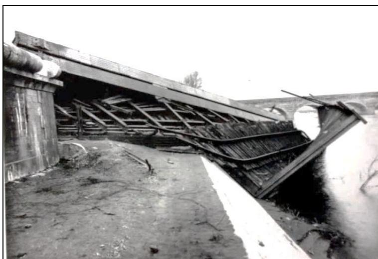
**Photo III.2 Les débris du pont Cacor emportés par la crue non-loin du Pont Canal
